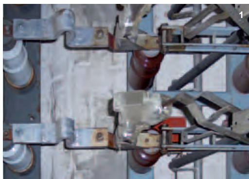
1 Teil eines alten Mittelspannungsschalters (Typ LHTCI) 2 Neue Trafostation Mozartstraße 3 Alter Traforaum der Station Färberweg
